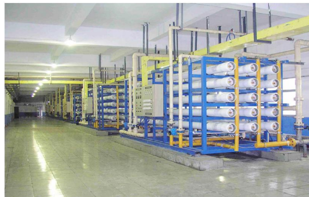
中国长城铝业公司热电厂 6 \times 75 \text{ m}^3/\text{h} 反渗透除盐工程 上海同济水处理技术开发有限公司承建
