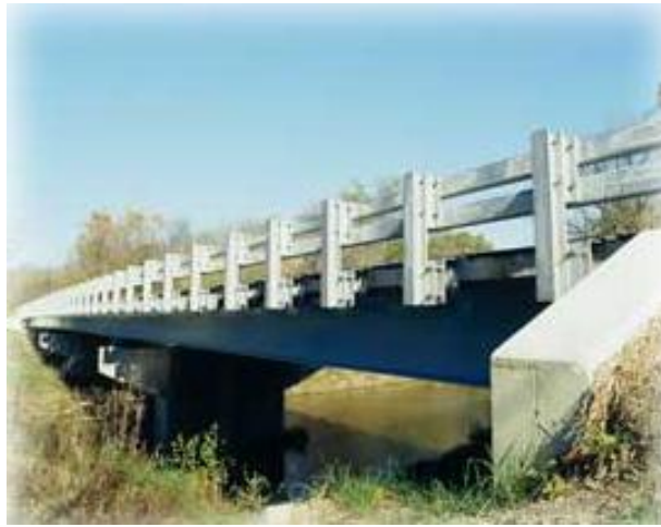
图 3 纤维塑料 - 钢组合梁桥
