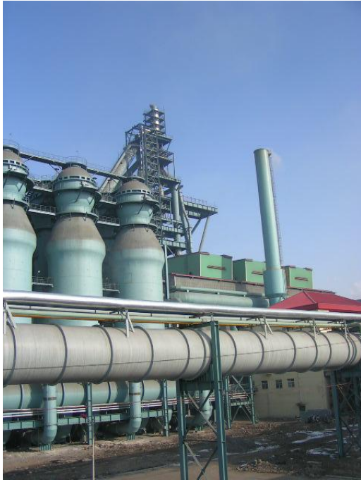
采用同济设计工业水处理系统的鞍山 3700 立方米高炉
