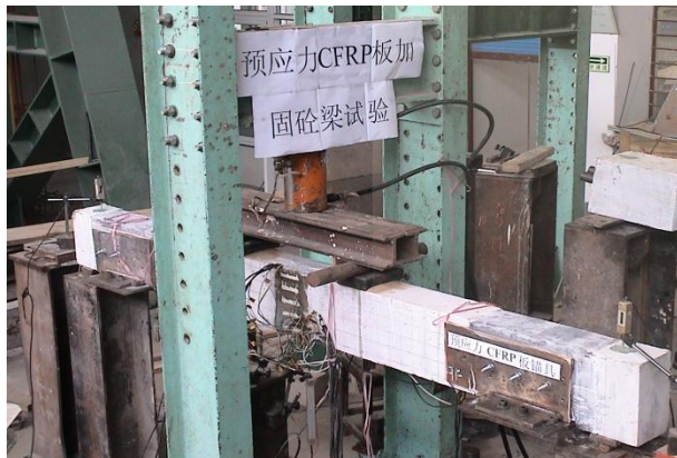
图3 预应力碳纤维板加固混凝土梁静力试验
